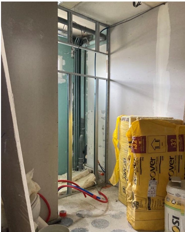
Figure 52. Début des travaux côté meuble vasque
