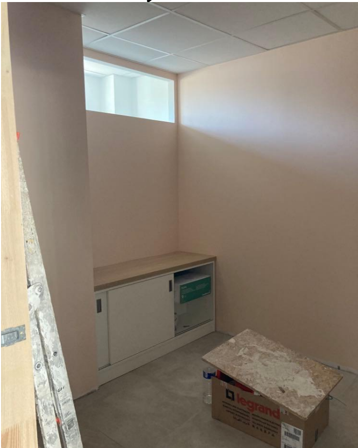
Figure 54. Mise en place du meuble vasque
