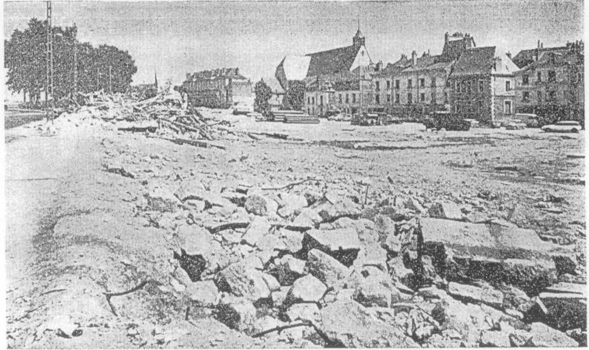
L'emplacement de la future Faculté des Lettres en préparation (PHOTO ARSICAUD)
