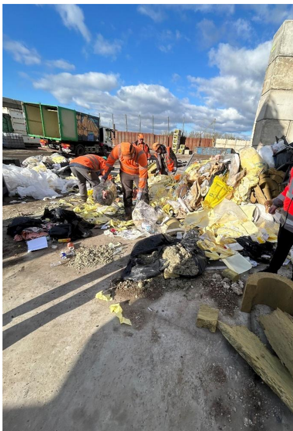
Photo 3 : Séparation visuelle des différentes matières selon les 7 flux obligatoires lors de la caractérisation par les équipes de Rouvreau Recyclage
