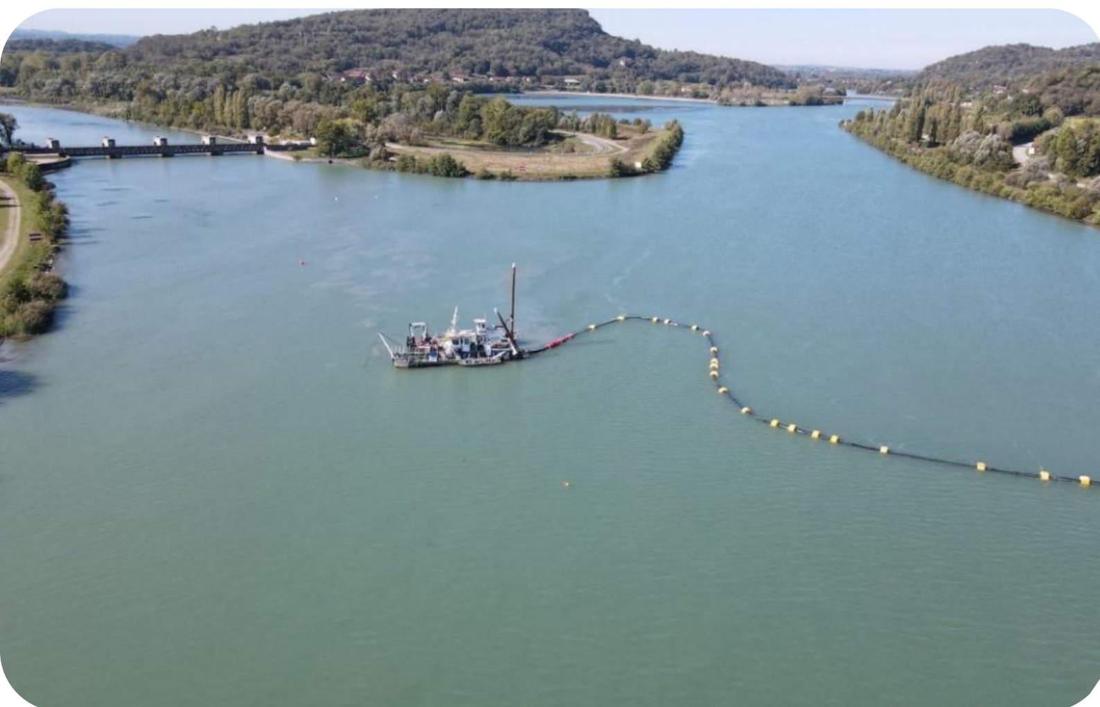
Photo d'une drague aspiratrice sur le barrage de Champagneux dans retenue de Bregnier-Cordon (CNR)
