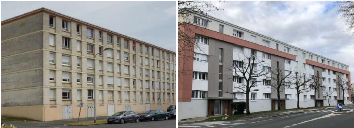
Figure 8 : Rénovation de la copropriété “Les Églantines” (avant/ après) Source : Reynaud Rebaudieres
