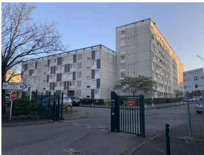
Figure 5 : Copropriété Ménival (Saint-Priest, métropole de Lyon) Source : Le Progrès
