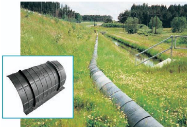
Figure 16: Bordure incurvée en plastique recyclé (Cerema 2021, d'après Groupe ACO)
