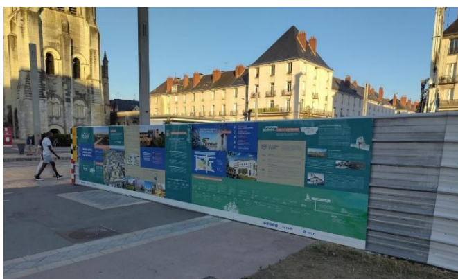
Figure 17. Photographie du panneau installé sur une palissade de chantier
