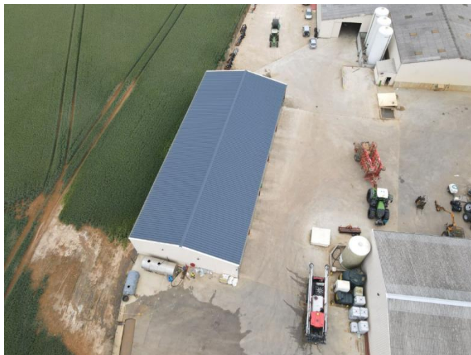
Figure 19 : Photo bâtiment 1 et de son environnement avant notre intervention
