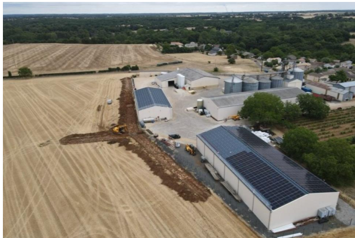
Figure 21 : Pose des modules photovoltaïques
