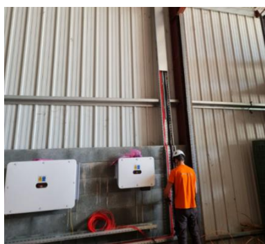
Figure 23 : Réalisation d'une zone technique
