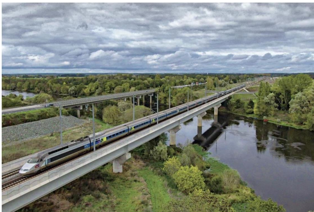
Figure 3 : Photo de la LGV SEA entre Tours et Bordeaux
