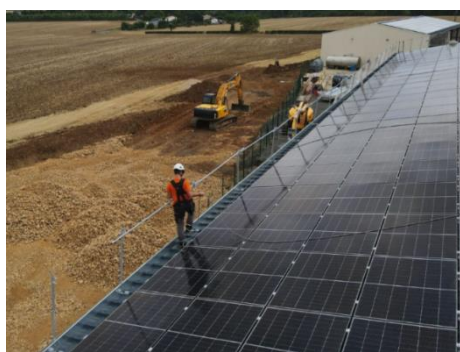
Figure 24 : Dépose de la sécurité collective
