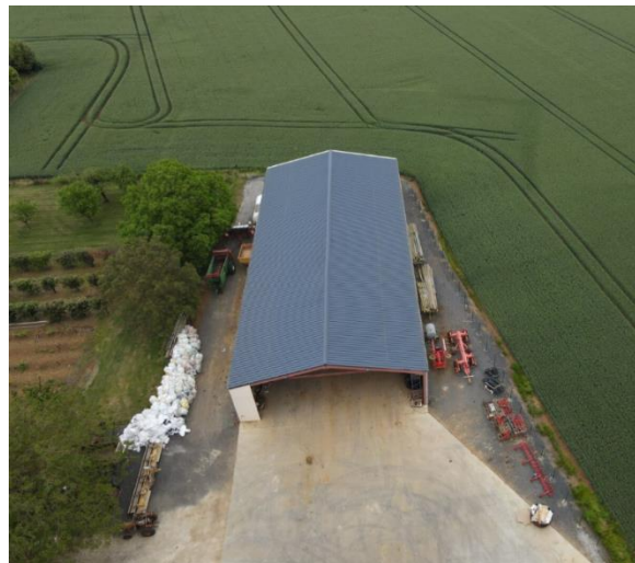
Figure 20 : Photo du bâtiment 2 et de son environnement avant notre intervention
