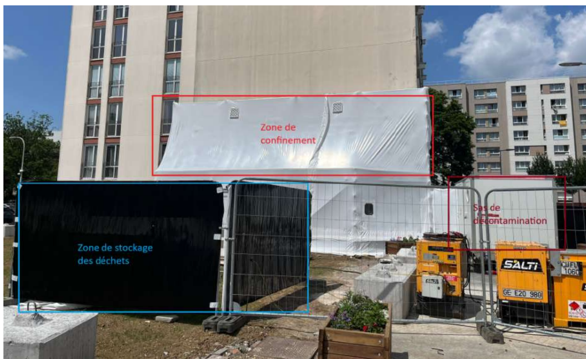
Figure 5: Les différents équipements du désamiantage du pignon de Blanc-Riez.
