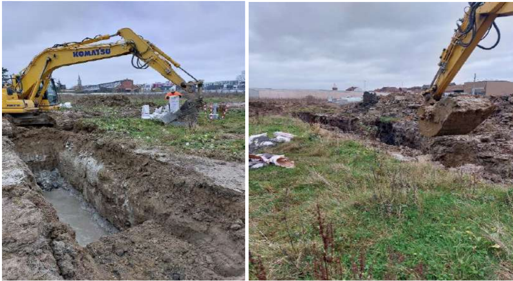
Figure 12: Réalisation des tranchées de malaxage.
