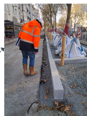
Vérification de l'implantation des bordures (source : Aline Maillochon)
