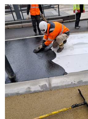
Réalisation de l'asphalte sur du feutre géotextile (source : Aline Maillochon)
