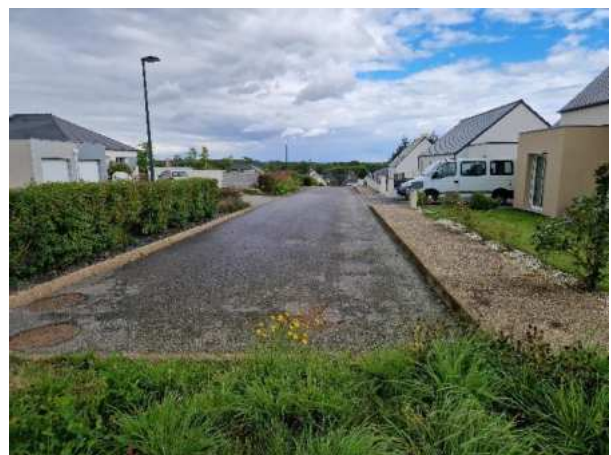
VUE 2-VUE SUR LA VOIE DE DESSERTE DES CHEVRONS
