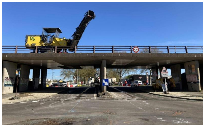
Figure 15 - Auto-pont de Rezé avant la démolition Source : Image personnelle
