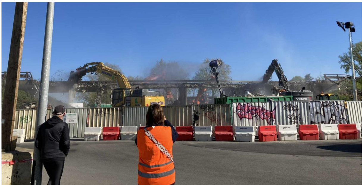
Figure 17 - Démolition de l'auto-pont de Rezé, le 08 avril 2025
