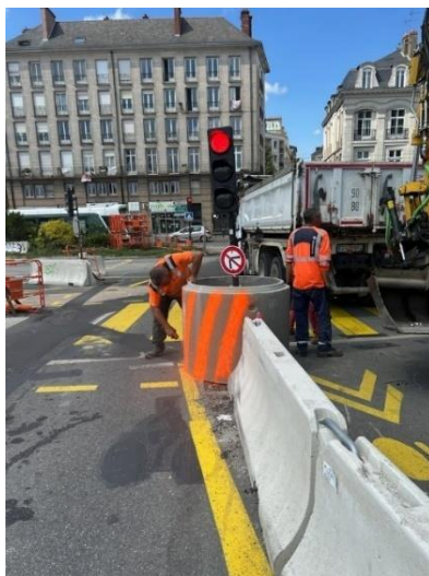
Figure 20 - Solution mise en place pour protéger le mât de signalisation tricolore Source : Image personnelle
