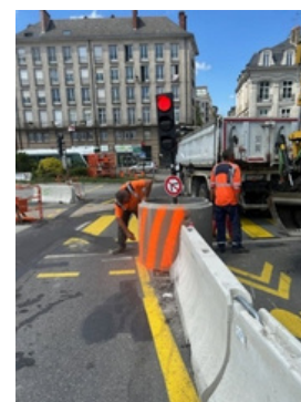
Figure 4 : Exemple d'usage : levée de réserve pour sécurisation d'un mât de signalisation. Source : image personnelle
