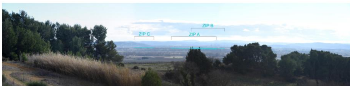
Figure 75 : Vue de la ZIP depuis la D67
