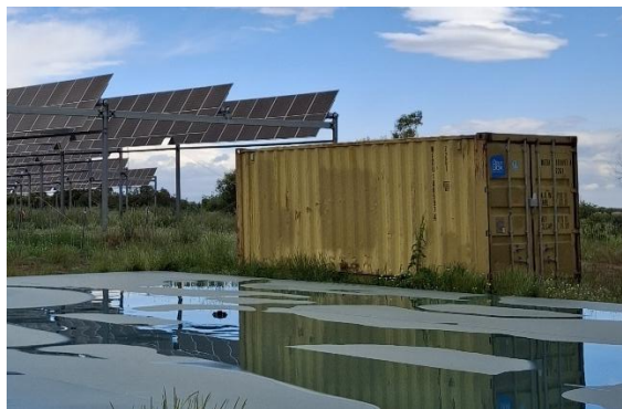
Figure 45 : Bâtiment de stockage à Terrats 2
