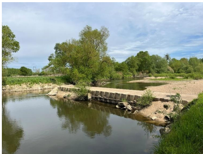
Figure 18: Ouvrage de Bron actuel @M.Garnault
