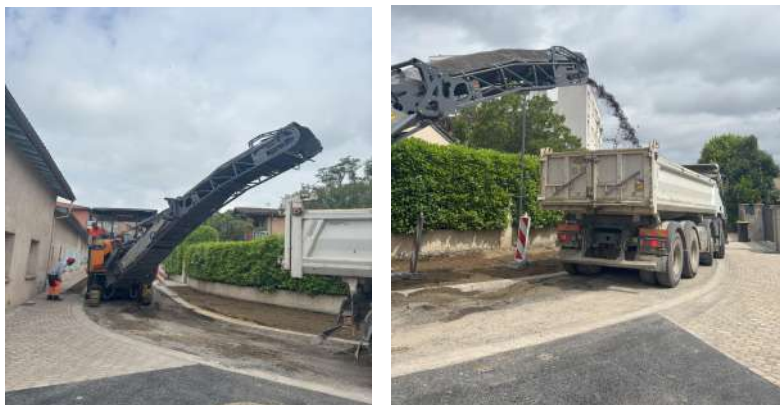
Figure 15 : Rabotage sur la rue de Fonsorbes, à Blagnac - photos personnelles
