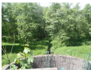
Figure 6 : Déversoir du bassin avant travaux (source : SIAHVY)
