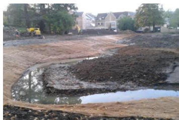
Figure 13 : Travaux de reméandrage sur 175m à l'emplacement de l'ancien plan d'eau « est » (source : SIAHVY)
