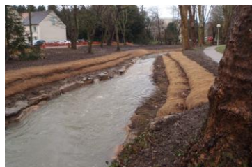
Figure 11 : Travaux de restauration du secteur en amont du système de vannage dit "de la copropriété" (source : SIAHVY)
