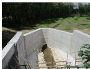
Figure 7 : Déversoir du bassin après travaux (source : SIAHVY)
