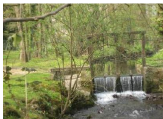
Figure 10 : Système de vannage dit "de la copropriété" (ROE 55552) (source : SIAHVY)
