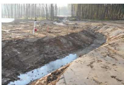
FIGURE 3 : TRAVAUX DE TERRASSEMENT DU NOUVEAU LIT (2014)
