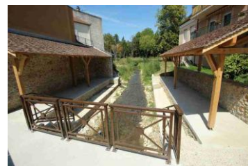
Figure 15 : Configuration actuelle du pont de l'avenue du général Leclerc (source : SIAHVY)
