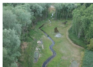
FIGURE 5 : VUE AERIENNE DU NOUVEAU LIT CREE A N+1 (2015)
