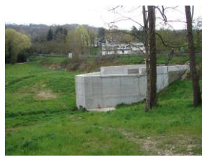
Figure 8 : Déversoir du bassin en conditions hydrologiques classiques (source association VYF)
