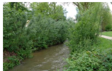
Figure 12 : Secteur restauré en amont du système de vannage dit "de la copropriété" (source : SIAHVY)
