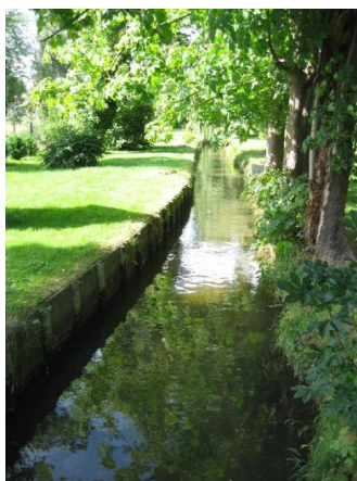
Figure 1 : Ancien bras rectiligne comblé dans la propriété du moulin de Gibeciaux (Source : SIAHVY)
