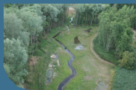
Nouveau lit créé en fond de talweg (secteur 1)
