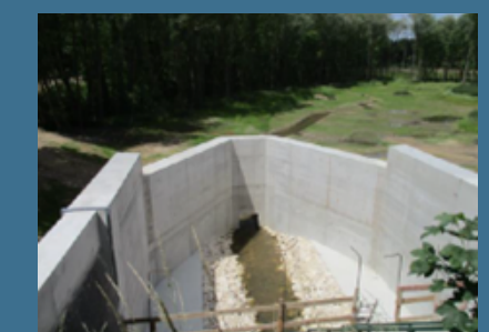
Nouveau déversoir du bassin (secteur 1)
