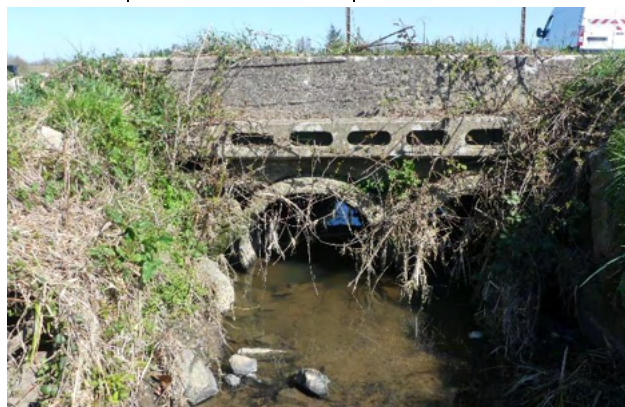
Figure 70 - OH02 Vue depuis l'aval (18/03/2025)
