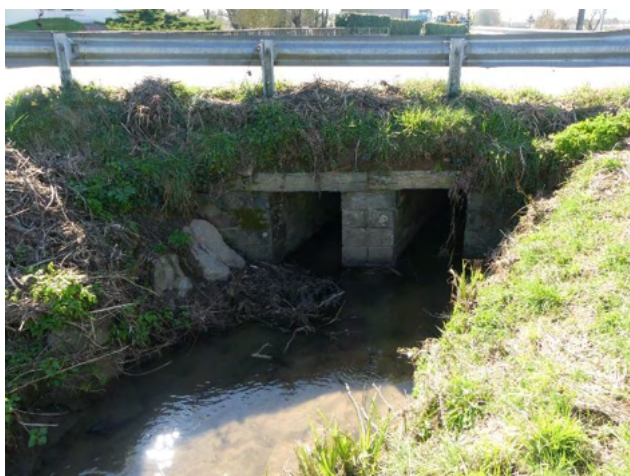
Figure 73 – OH04 Vue depuis l'amont (18/03/2025)
