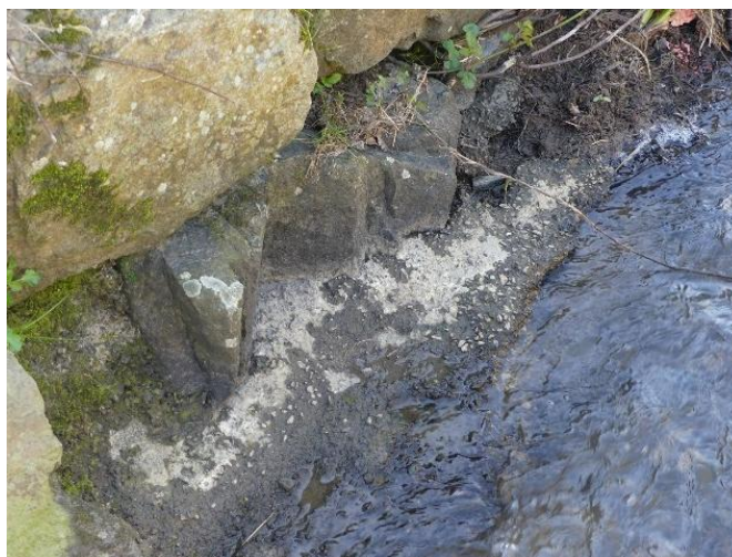
Figure 26 -- Substrats artificiels en pied de berge
