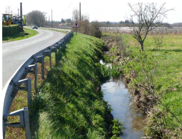
Figure 16 - Vue sur le segment 10 vers l'aval
