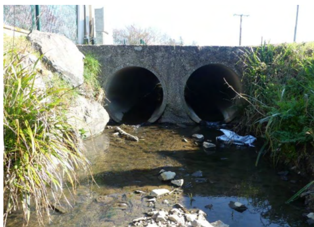
Figure 68 – OH01 Vue depuis l'aval (18/03/2025)
