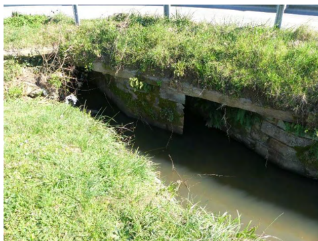
Figure 74 – OH04 Vue depuis l'aval (18/03/2025)
