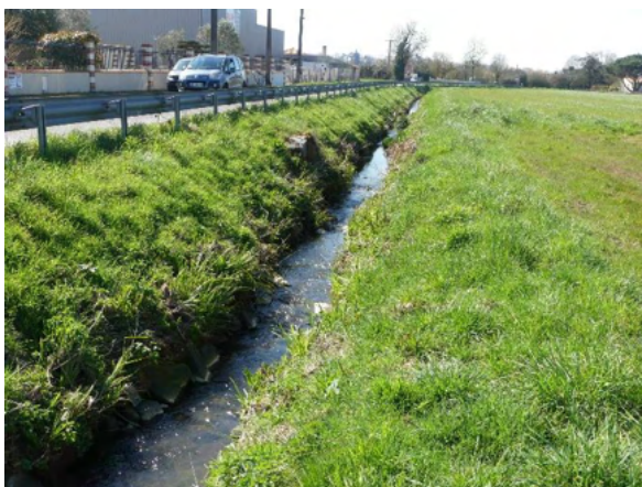
Figure 15 - Vue depuis l'amont du segment 05
