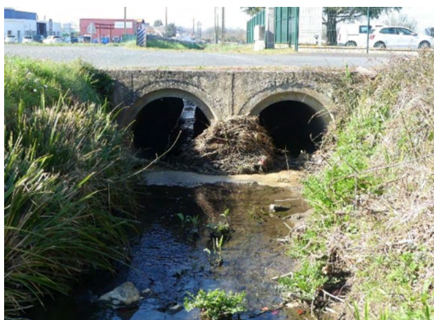
Figure 67 -- OH01 Vue depuis l'amont (18/03/2025)
