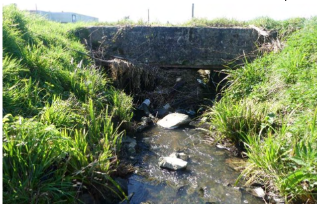
Figure 69 - OH02 Vue depuis l'amont (18/03/2025)
