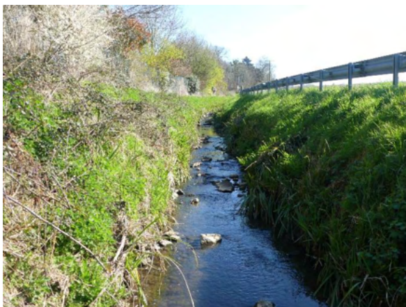
Figure 13 - Vue depuis l'aval du segment 01
