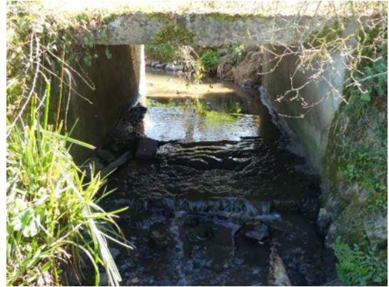
Figure 72 – OH03 Vue depuis l'aval (18/03/2025)
