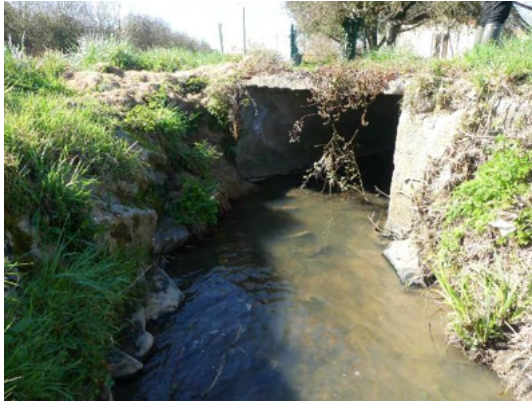
Figure 71 – OH03 Vue depuis l'amont (18/03/2025)
