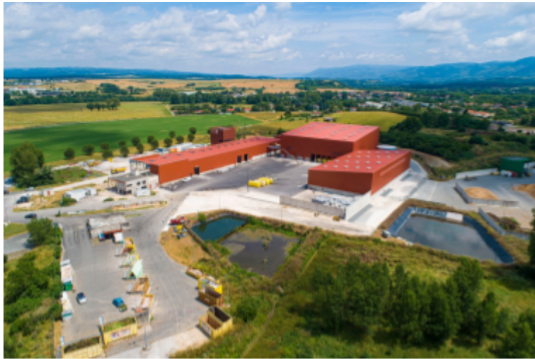
Figure 6 : Centre de tri de la collecte sélective, Labruguière - Source : Trifyl
