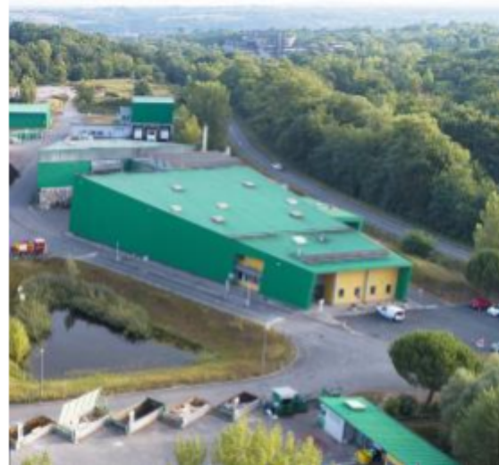
Figure 7 : Unité de tri du tout-venant, Blaye Source : Trifyl
