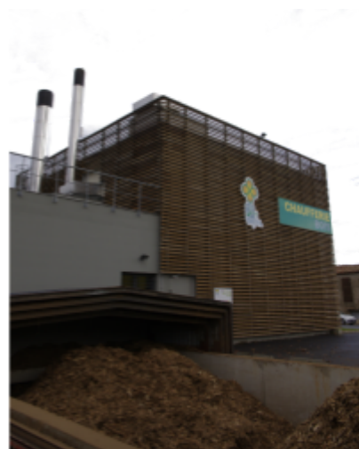
Figure 11 : Exemple de chaufferie - Source : Trifyl
