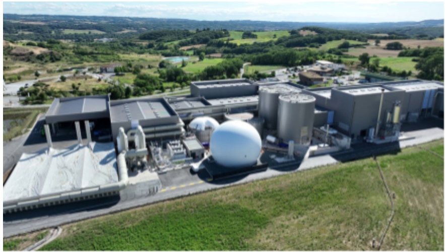
Figure 8 : Unité de tri et de valorisation des déchets, LabEnergia - Source : Trifyl
