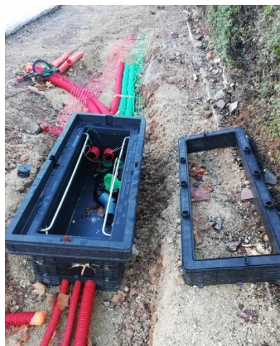
Figure 22 : Chambre de tirage, Prévention BTP
