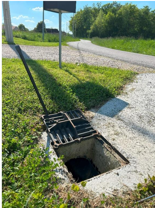
Figure 26 : Ouverture d'un regard pour mesure de fil d'eau, Enzo GENNARO
