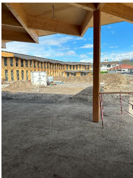
Figure 25 : Chantier de Pontcharra, Enzo GENNARO
