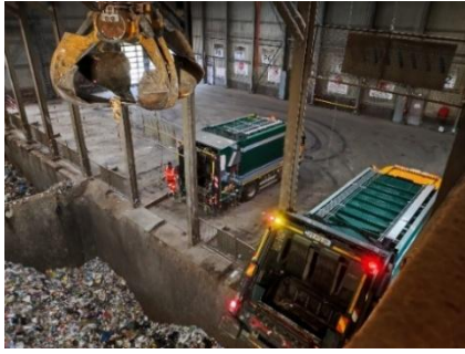
Figure 15 : Déchargement des camions, SICTOM Sud-Allier (2016)
