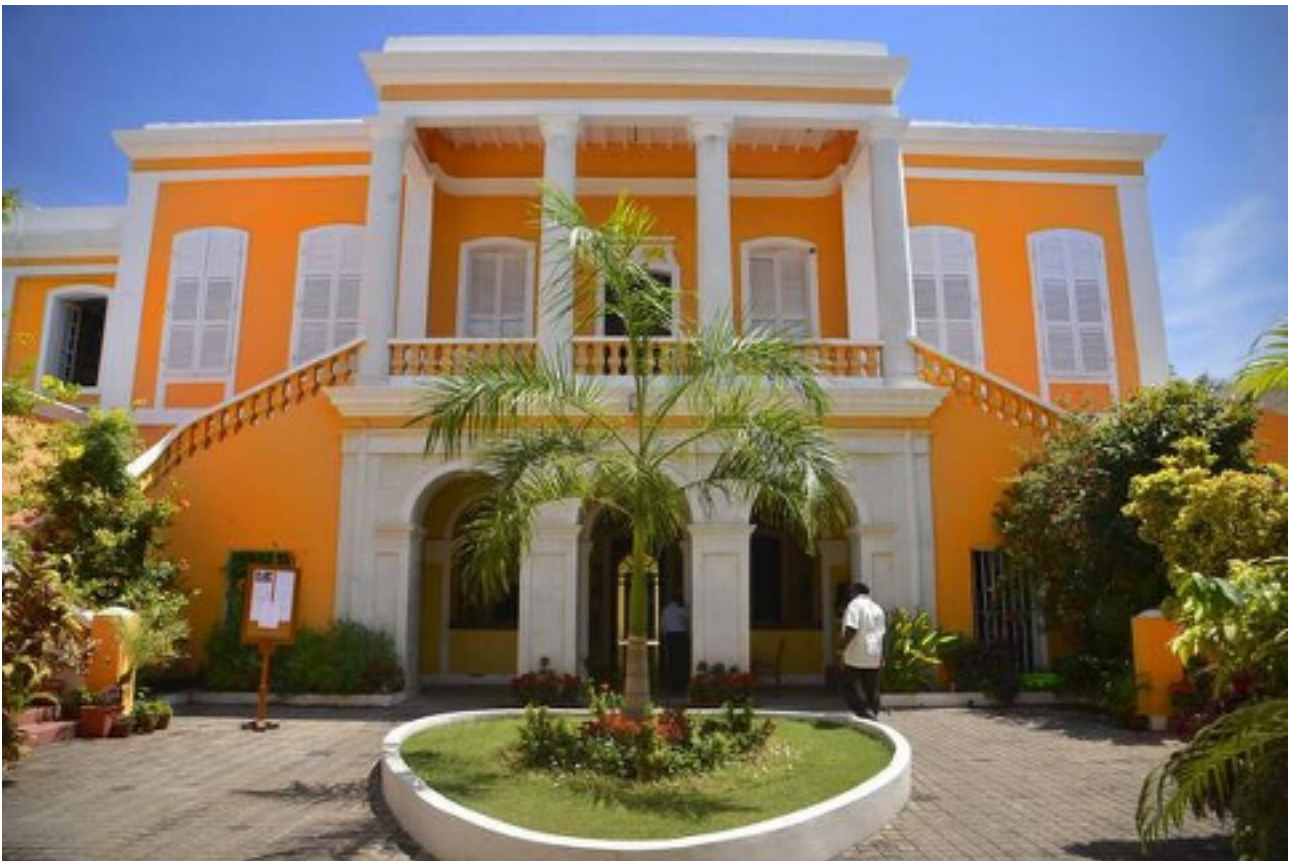
Figure 1 : Façade de l'IFP
