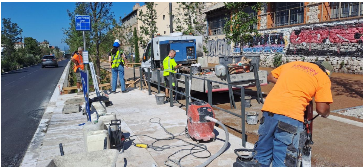
Figure 14 : Implantation du mobilier RTM : en haut, repérage sur site de l'emplacement du poteau d'arrêt (point rose) ; en bas, mobilier installé après validation des implantations sur site. (Source : Nolwenn Boubakar)
