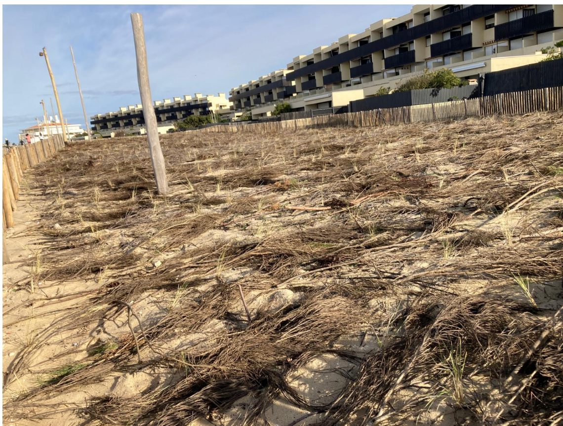
Figure 12 : Revégétalisation des dunes lors du projet de réaménagement des espaces du front de mer de Lacanau : plantation d'Oyat (Durand, 2025).
