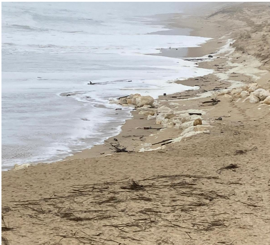
Figure 5 : Destruction des enrochements de protection lors de la tempête de 2014 (Durand, 2014)
