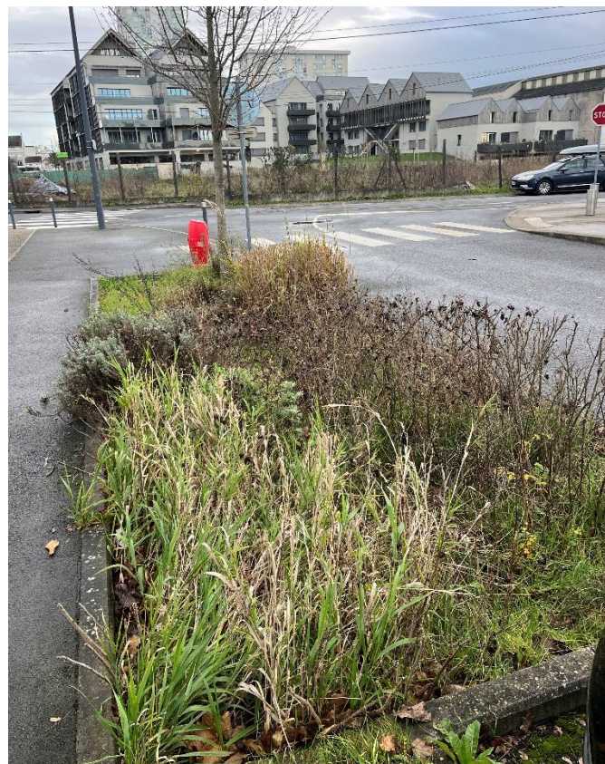
Figure 12 : Photo de la troisième noue paysagère d'infiltration. Source : Glwadys Dongois, 2024.
