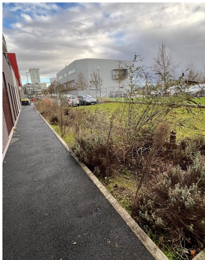
Figure 10 : Photo de la première noue paysagère d'infiltration. Source : Glwady Dongois, 2024.
