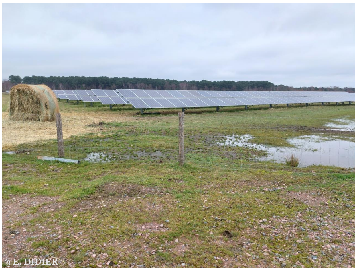
Figure 1 : Parc photovoltaïque de Sonzay, janvier 2024
