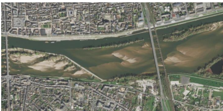
Figure 12 : Secteur avec des duits et ponts à Orléans
