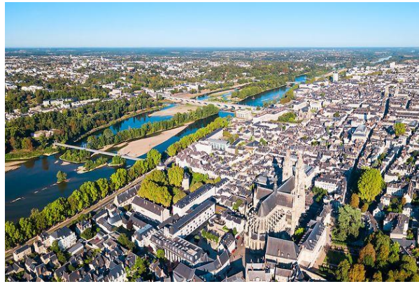
Figure 5 : Plaine d'inondation contrainte en contexte urbain à Tours (source : saiko3p)
