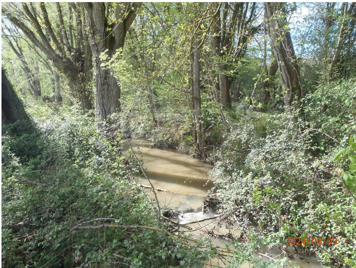
Figure 4 : Exemple de petits ouvrages en planche retrouvés sur le tronçon étudié
