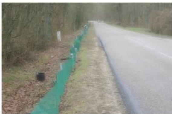
Figure 322: Dispositif temporaire bloquant le déplacement des amphibiens pendant quelques semaines (Source : A. Morand, Cerema Est)
