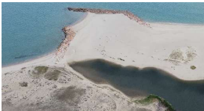
FIGURE 3 : PHOTO ILLUSTRANT L'IMPORTANT NIVEAU D'ENSABLEMENT DU DEBOUCHE (CASAGEC, 2023)
