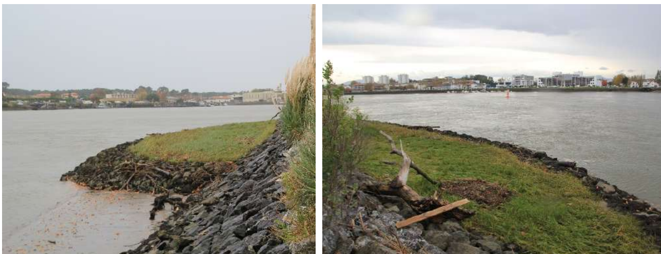
FIGURE 12 : PLATEFORME ARTIFICIELLE QUI S'ETEND SUR LE LIT DE L'ADOUR (BERGES DE SAINT BERNARD)
