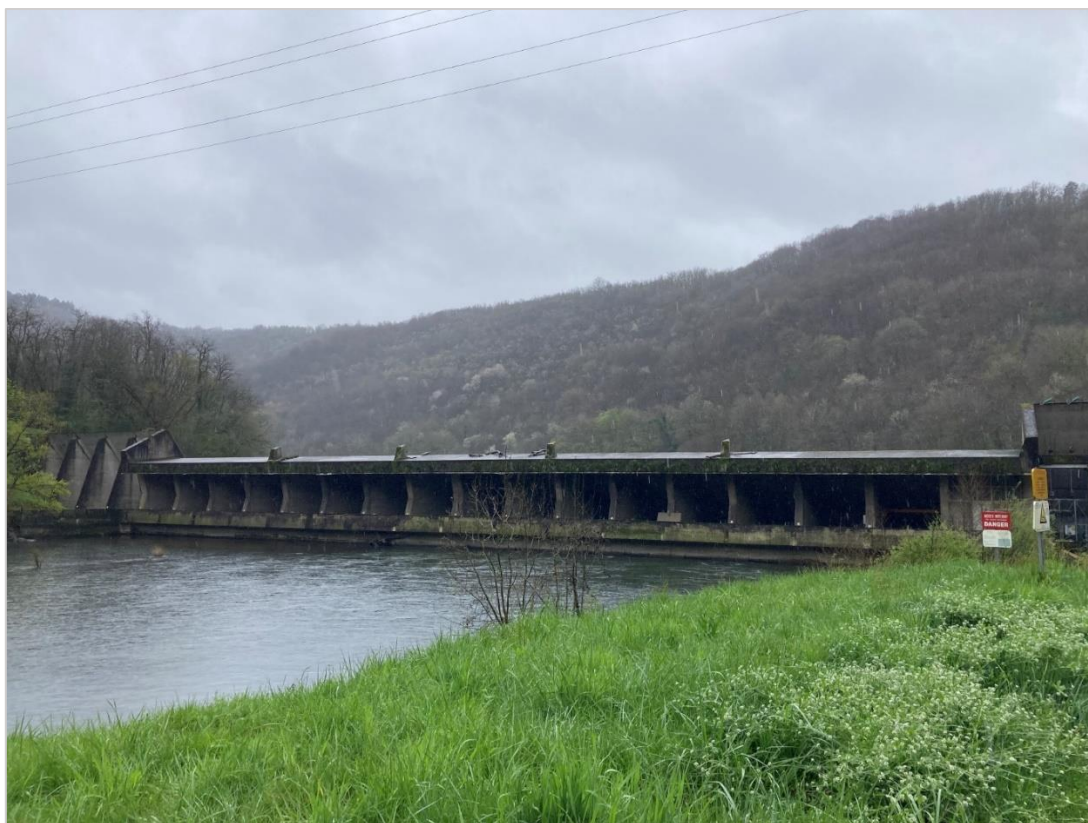
Figure 12 : Barrage-usine de Brugale sur la Cère aval (A. Rougeyres)
