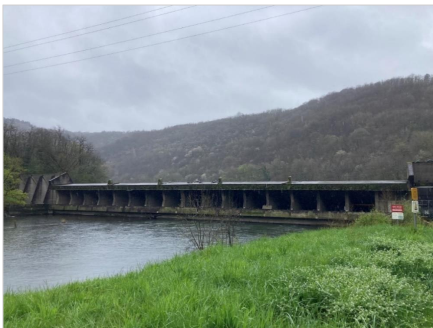
Figure 2 : Barrage-usine de Brugale sur la Cère aval (A. Rougeyres)
