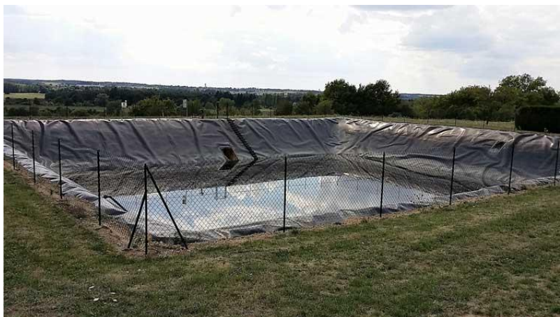
Figure 14 : Exemple d'un bassin de rétention des eaux incendies (Source : CYRUS)
