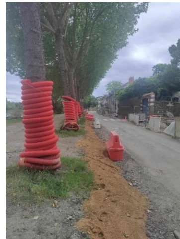
Figure 15 : À la demande de la DPJP d'Angers, l'entreprise travaux a recouvert les racines apparentes des platanes de la promenade de Reculée avec du sable pour prévenir un éventuel dessèchement. (© J.LARGUET)
