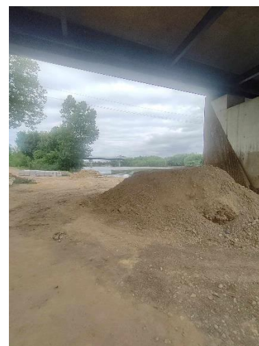
Figure 12 : Zone de stockage temporaire de matériaux sur le chantier 1 à proximité du cours d'eau (© J.LARGUET, 2024) questionnant de la complexité (et l'utilité) d'aligner les actes sur les paroles tant cette zone semble idéale comme zone tampon pour les matériaux.
