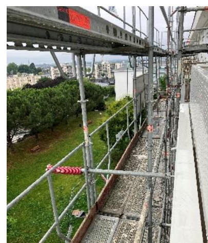
Figure 11 : Vue sur l'échafaudage monté manuellement pour la réfection d'une façade et vue sur le parc adjacent - Chantier 2 19/06/2024 (©J.LARGUET)
