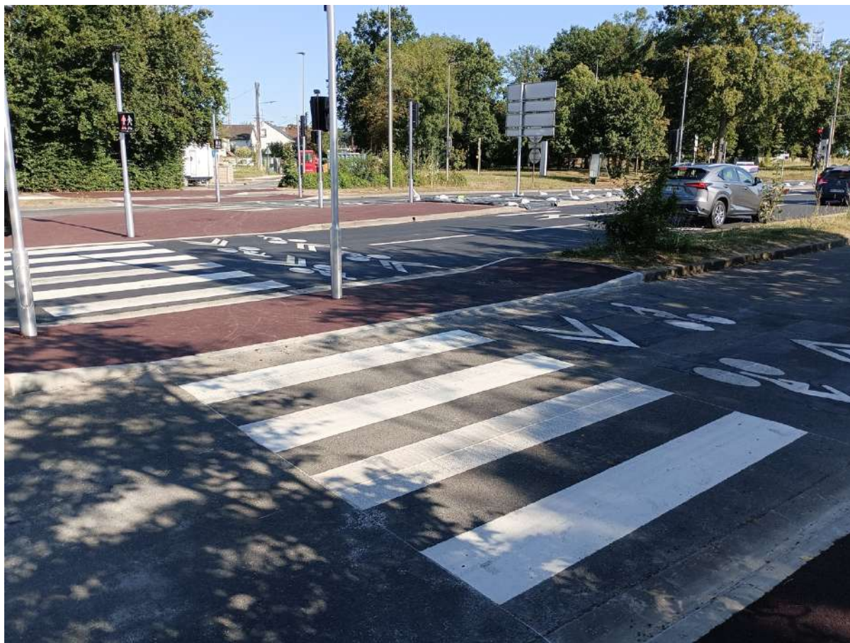
Fig. 22, Carrefour 519 après travaux, source : Y. KERAMPRAN, 2024
