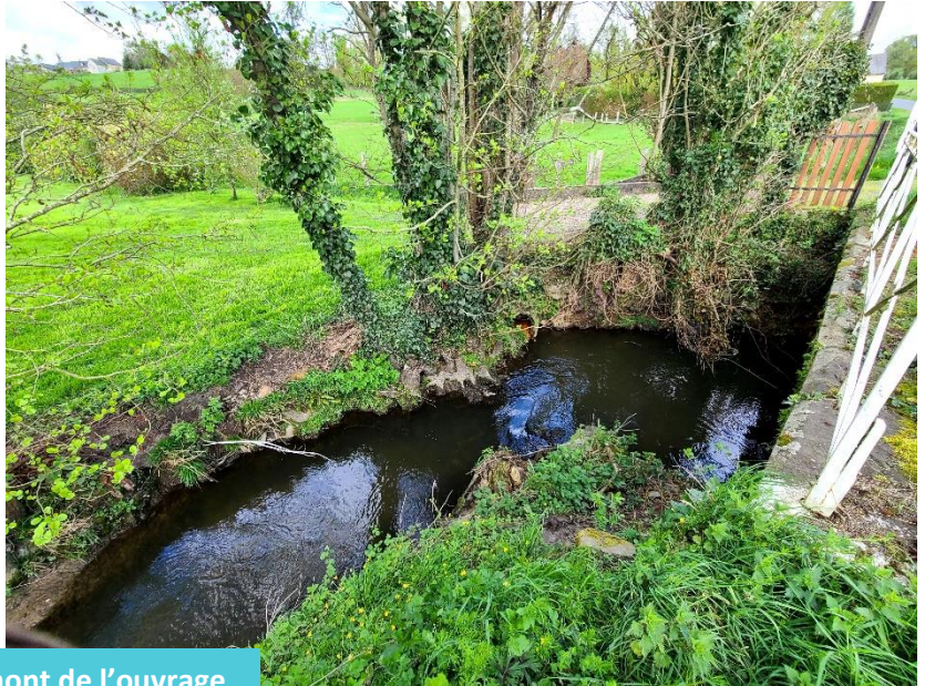
Amont de l'ouvrage
