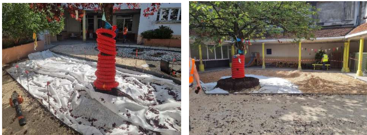
Figure 17 : Avancée des travaux le 2 août 2024 – École élémentaire Menuts – Léo BONNIN
