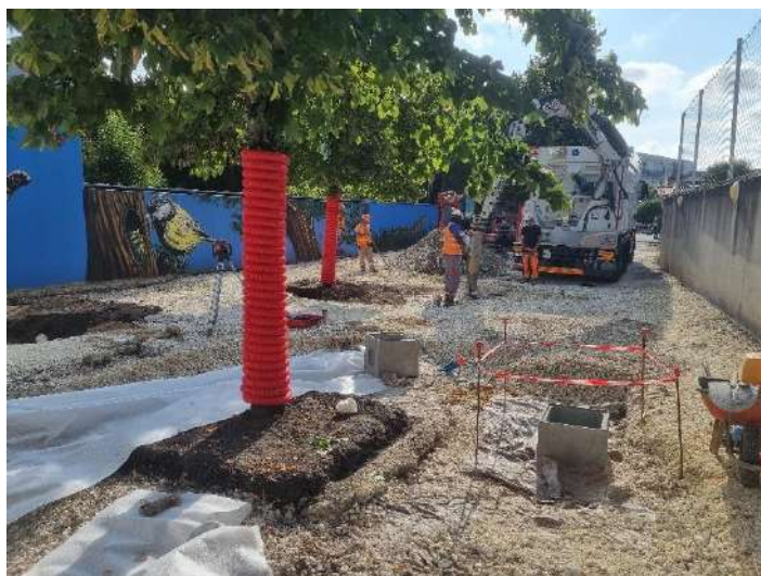
Figure 21 : Avancée des travaux le 2 août 2024 – Crèche Jean Marquaux – Léo BONNIN
