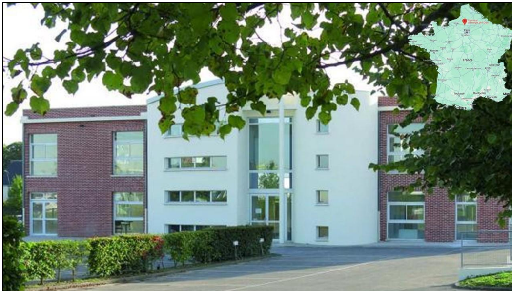
Figure 1 : Bâtiment du Syndicat de l'Energie de l'Oise (©SE60)
