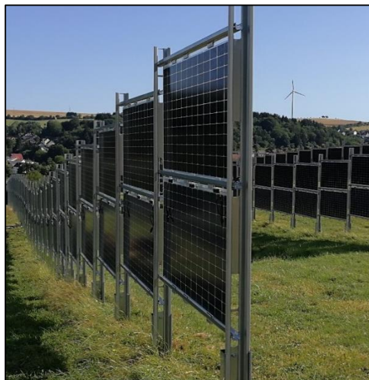
Figure 8 : Panneaux bifaciaux verticaux (©Next2Sun)
