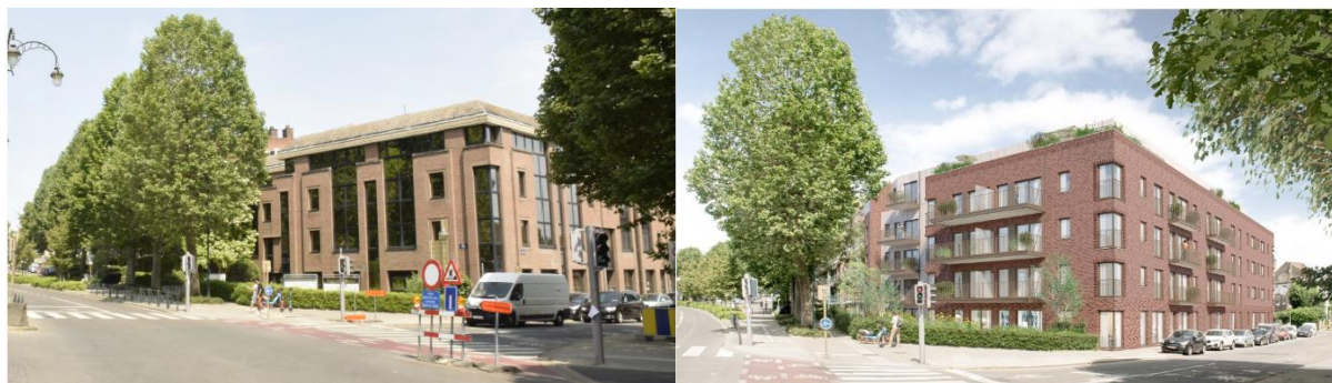
Figure 6 : Photo avant/après du projet PAGODES
