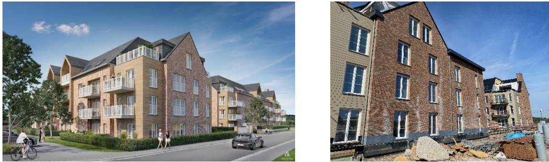
Figure 9 : Image d'architecte du projet Val d'Eugène et photo de l'état actuel des travaux
