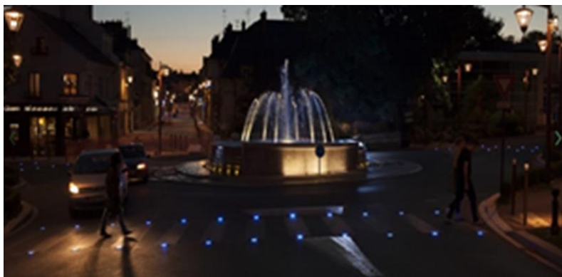
FIGURE 12 : SECURISATION D'UN PASSAGE PIETON AVEC DES PLOTS SOLAIRES ENCASTRES ©KAROLINA SAMBORSKA
