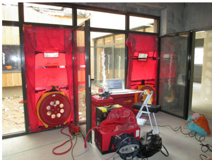
Figure 15 : Réalisation d'un test d'étanchéité à l'air
