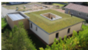
Figure 15 : toiture végétalisée – © Construire Sa Maison
