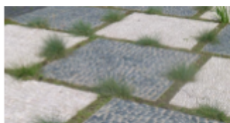
Figure 14 : revêtements perméable – © Cité Verte
