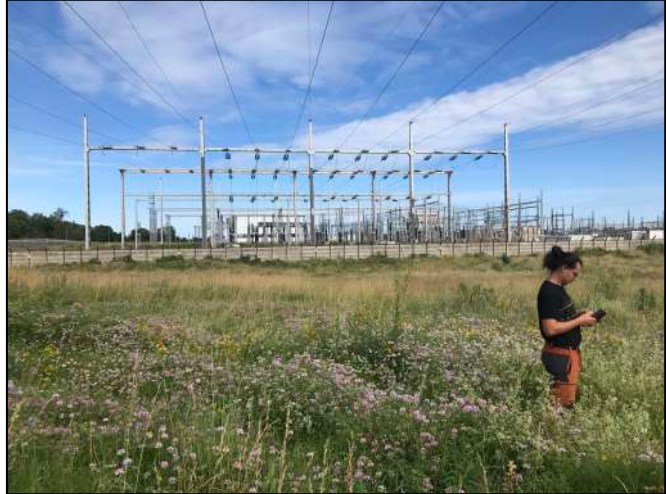
Figure 30. Réalisation de l'inventaire au niveau du premier pylône (Photo : A. Moreno)
