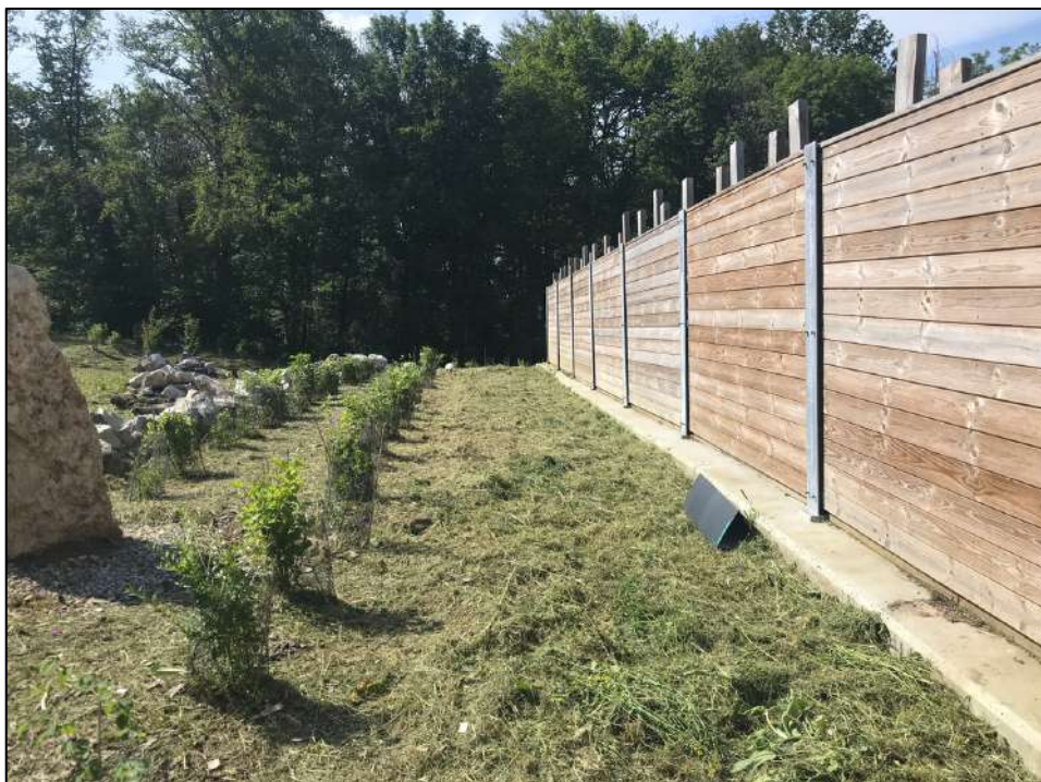
Figure 14. Exemple d'installation du tunnel le long des panneaux (Photo : A. Moreno)
