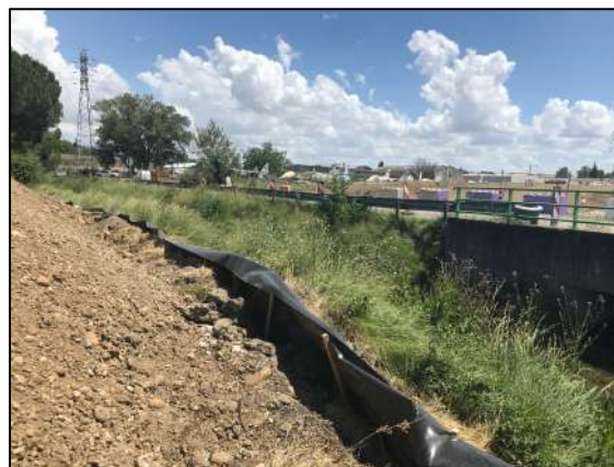
Figure 28. Vérification de la mise en défens des amphibiens aux abords du chantier (Photo : A. Moreno)
