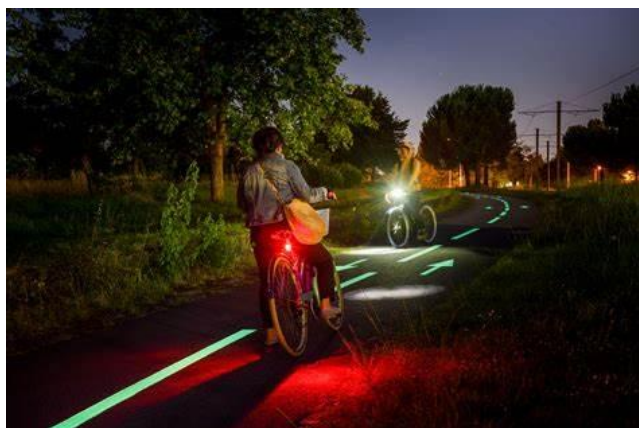
Figure 59 : Exemple de marquage au sol photoluminescent
