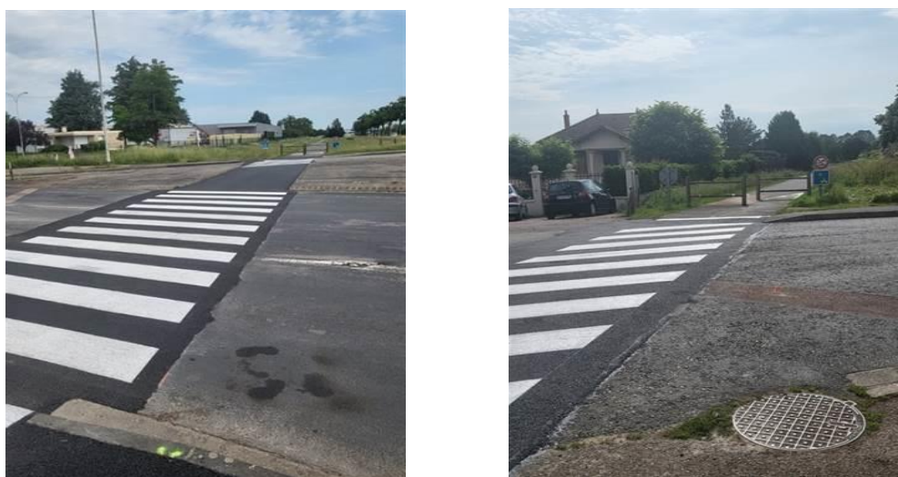
Figure 47 : Ragréage des voies cyclables de Polygone et Albert Thomas
