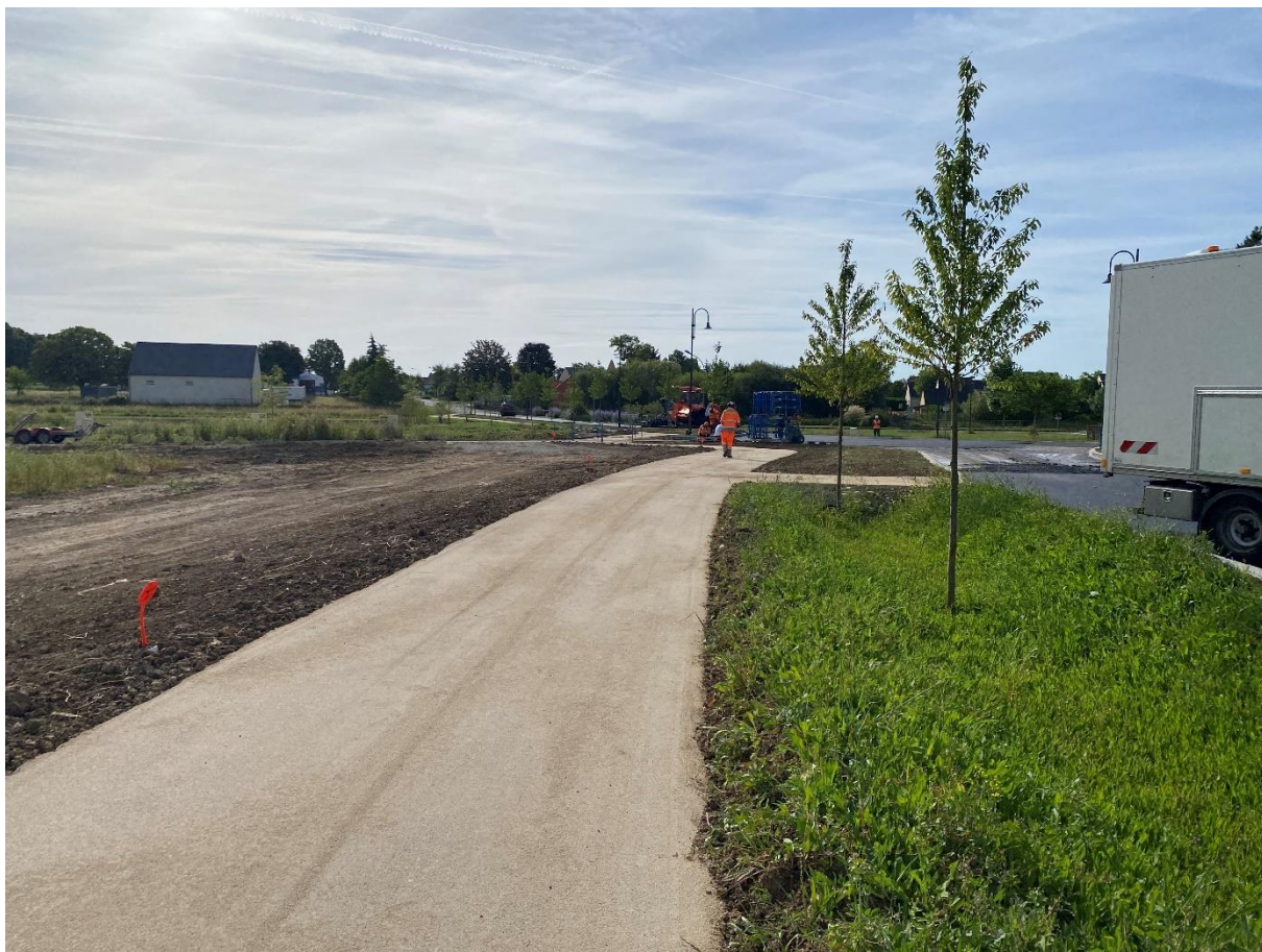
Figure n°18 : Travaux de voiries sur une zone d'aménagement la veille de l'inauguration
