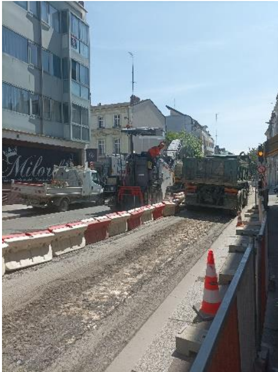
Figure 8 : Photo du rabotage de la voirie rue Marceau
