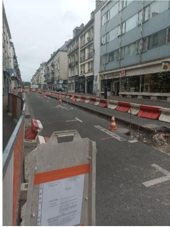
Figure 9 : Photo des tranchées pour les bordures séparatrices rue Marceau
