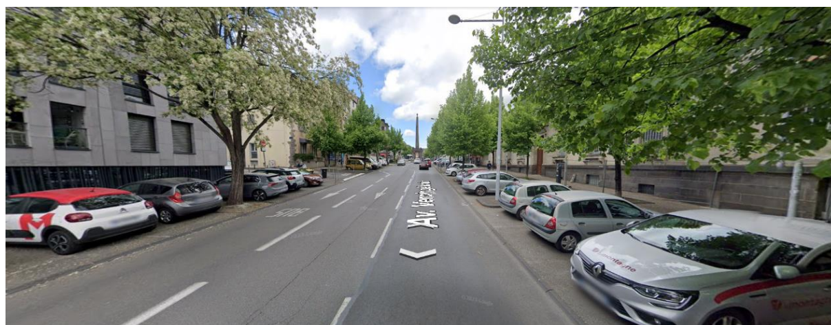
Avenue Vercingétorix avant travaux (Source : Google, 2024)
