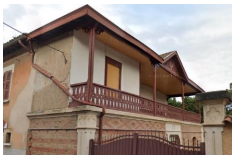
Figure 8 : Maison conservée pour le projet
