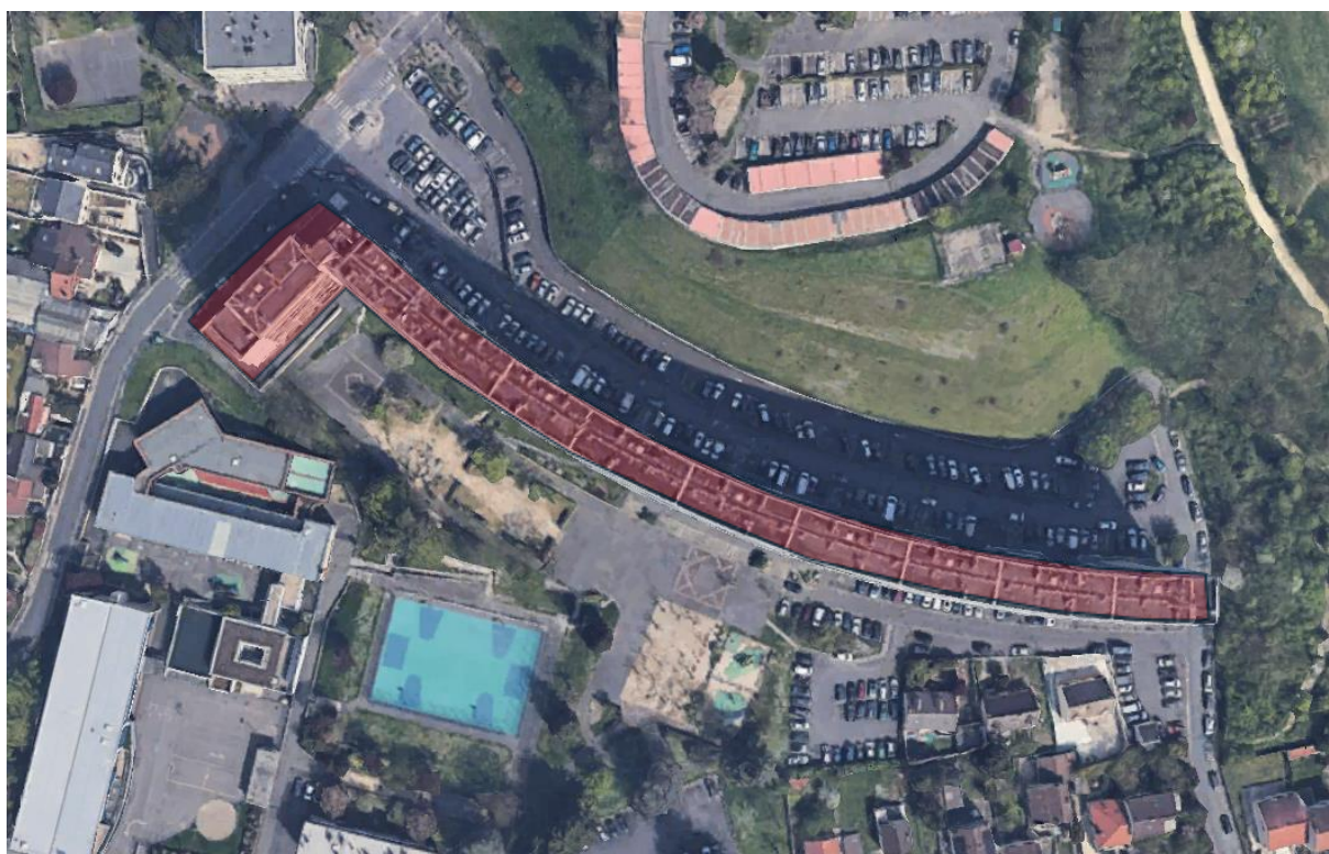
Figure 4 Photo aérienne de la Cité Champagne
