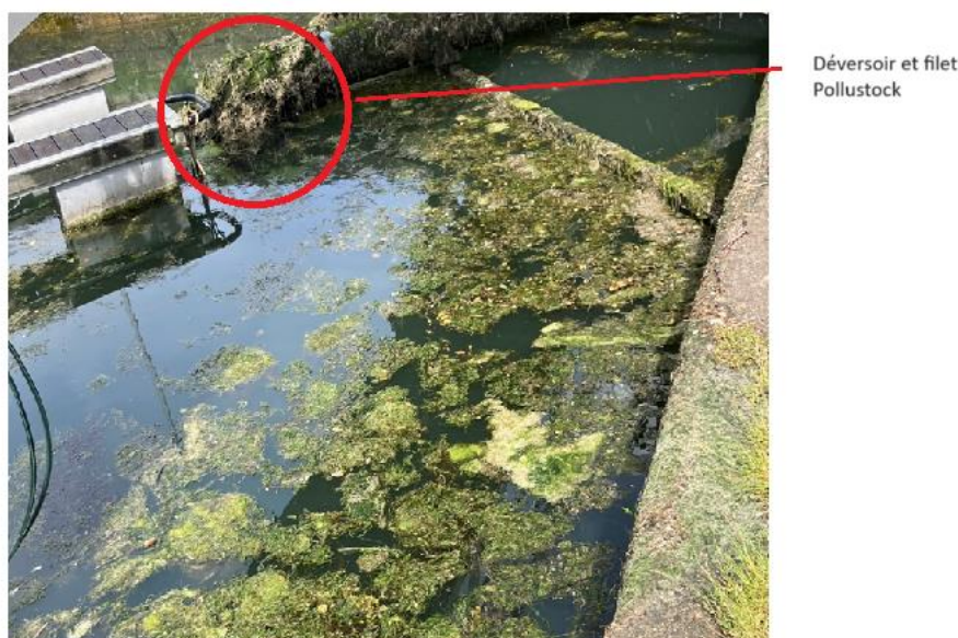
Figure 15 : Photo de la darse du vieux port et son accumulation de déchets et d'algues au niveau du déversoir d'eaux pluviales (Durand, 2024).
